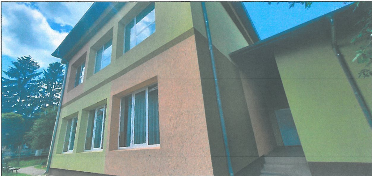
Fig. 1... 5- Construcție existentă – În curs de reabilitare si eficientizare energetica – exterior
