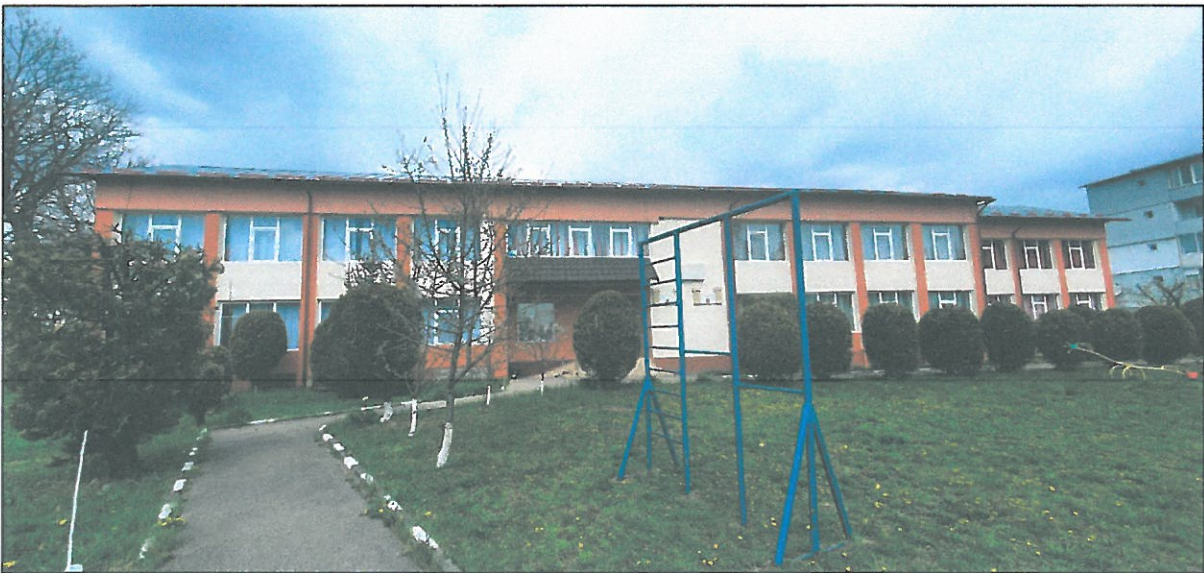
Fig. 1... 5- Construcție existentă – În curs de reabilitare și eficientizare energetică – exterior
