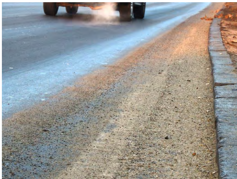
Figura 101. Mizeria care se adună în zona de circulație a bicicletelor și trotinetelor electrice scade aderența pneurilor și pune în pericol utilizatorii
