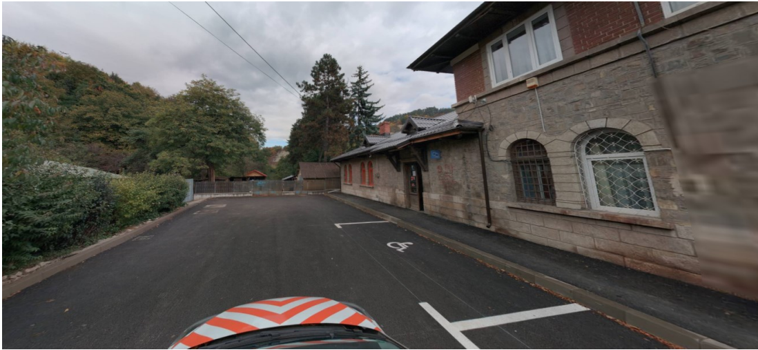
Figura Nr. 64 - Locuri de parcare pentru persoanele cu handicap – HC Breaza
