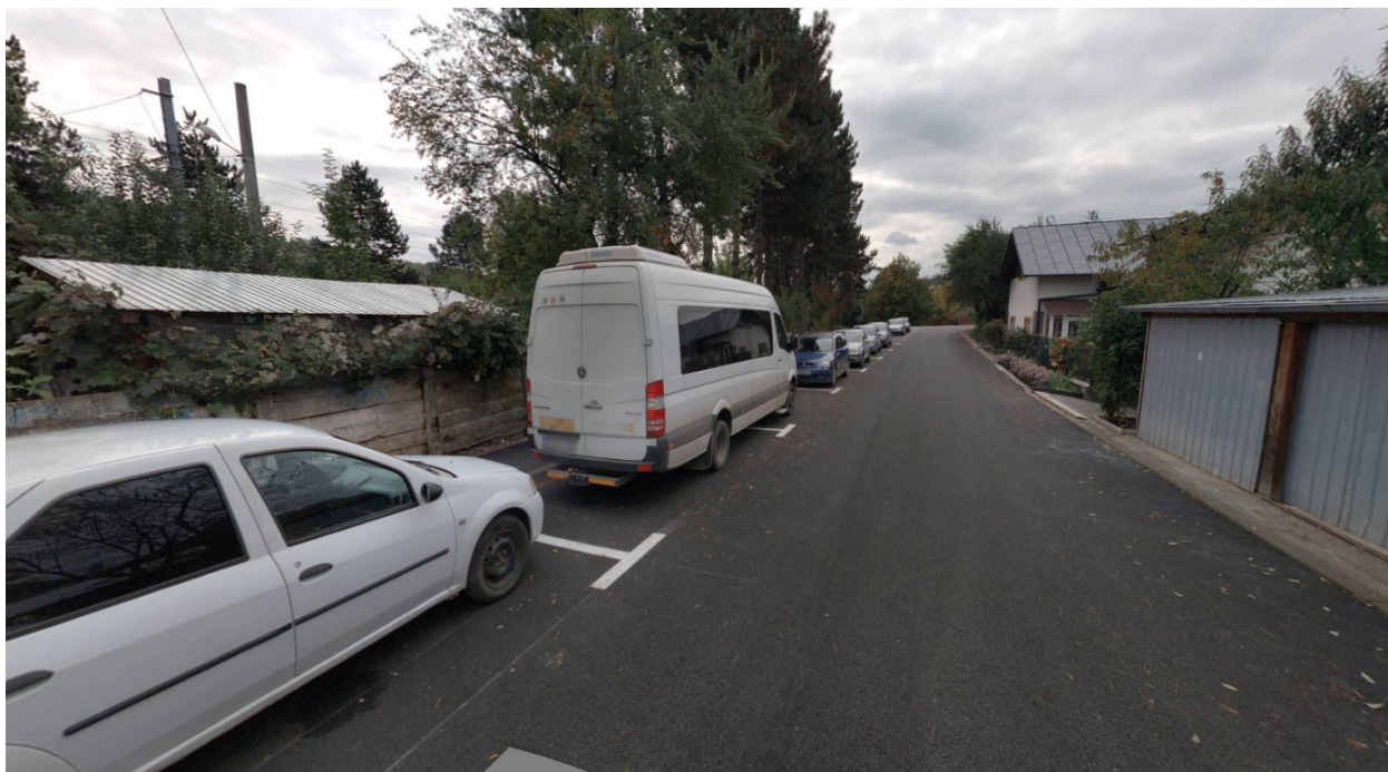
Figura Nr. 56 - Infrastructura rutieră reabilitată din bugetul local pe Str. Gării, cu parcări publice
